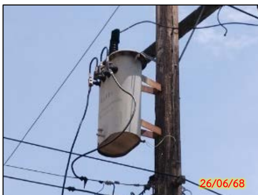
รูปที่ 2.2-5 หม้อแปลงไฟฟ้าของโครงการ
